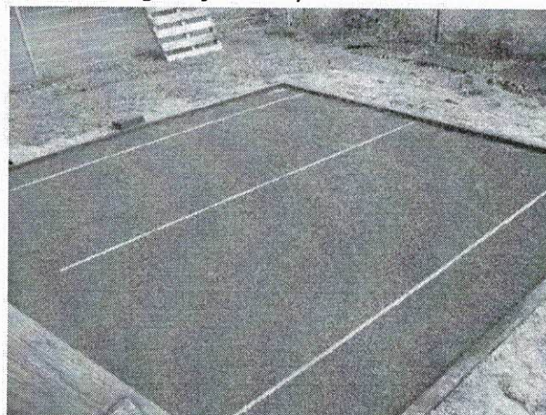
Wyrównanie górnej warstwy
